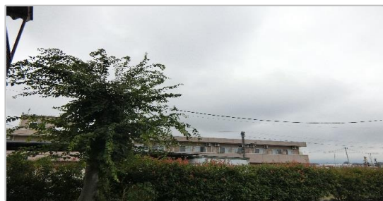
敷地内の緑化
